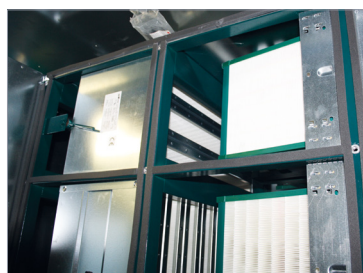
Det selvrensende forfilter er så effektivt at HEPA-filtrene belastes minimalt.
